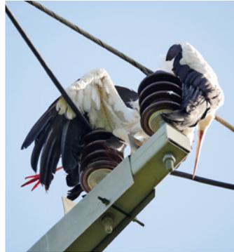
*Tödliche Gefahr durch falsche Sicherung (hier: zu kurze Traversen-Isolierung bei Gundelsheim).*
